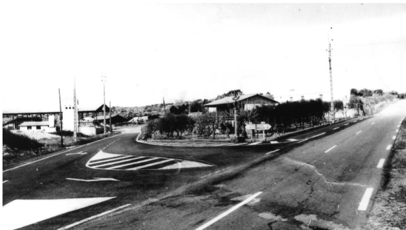
A gauche, extérieur de la mine au croisement des routes de Salinelles et Aspères.
