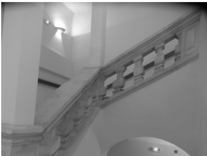
Escalier à balustres du 17 ème siècle, ancien couvent des Cordeliers (Photo G. Guiraudet)
