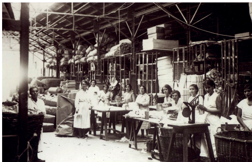
L'intérieur de l'usine Pagès, vers la fin des années 1930 (source : site papipacon)
